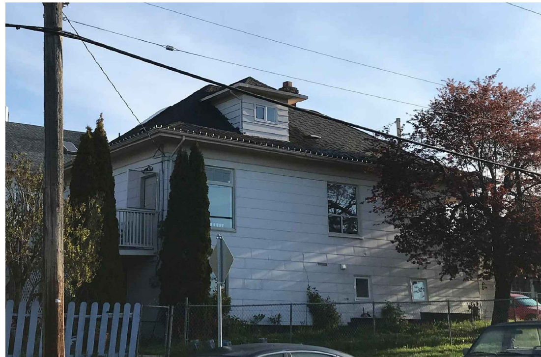
ASBESTOS SIDING
